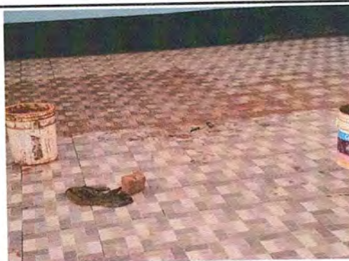
Foto 4: DURANTE EL TRABAJO DE COLOCACION DE NUEVO PISO
