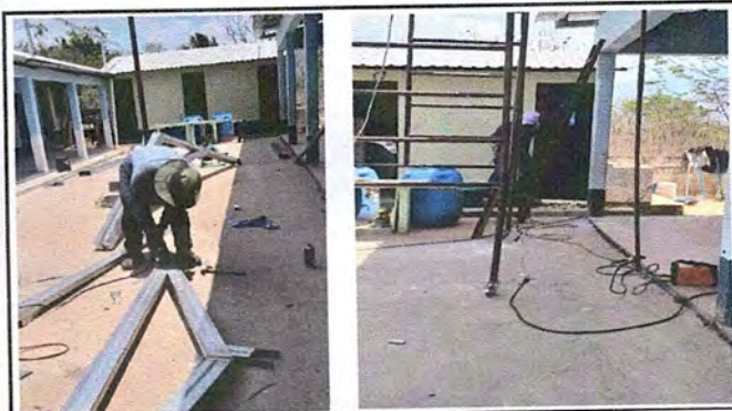
Foto 5: DURANTE EL TRABAJO DE COLOCACIÓN DE TECHO EN ÁREA DEL PATIO DONDE SE REALIZAN DIVERSAS ACTIVIDADES ESCOLARES
