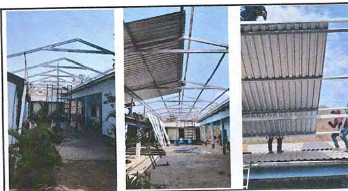
Foto 6: DURANTE EL TRABAJO DE COLOCACIÓN DE TECHO EN ÁREA DEL PATIO DONDE SE REALIZAN DIVERSAS ACTIVIDADES ESCOLARES
