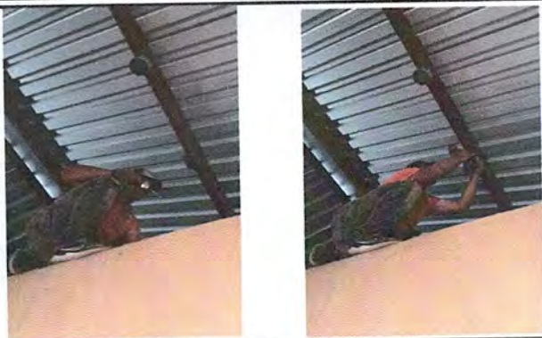
Foto1: DURANTE EL TRABAJO DE CAMBIO DE TODO EL SISTEMA ELÉCTRICO
