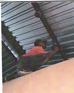
Foto 2: I DURANTE EL TRABAJO DE CAMBIO DE TODO EL SISTEMA ELÉCTRICO
