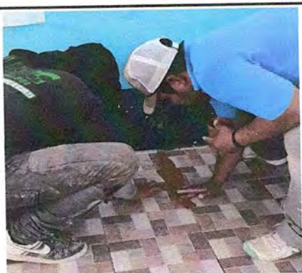
Foto 3: DURANTE EL TRABAJO DE COLOCACION DE NUEVO PISO
